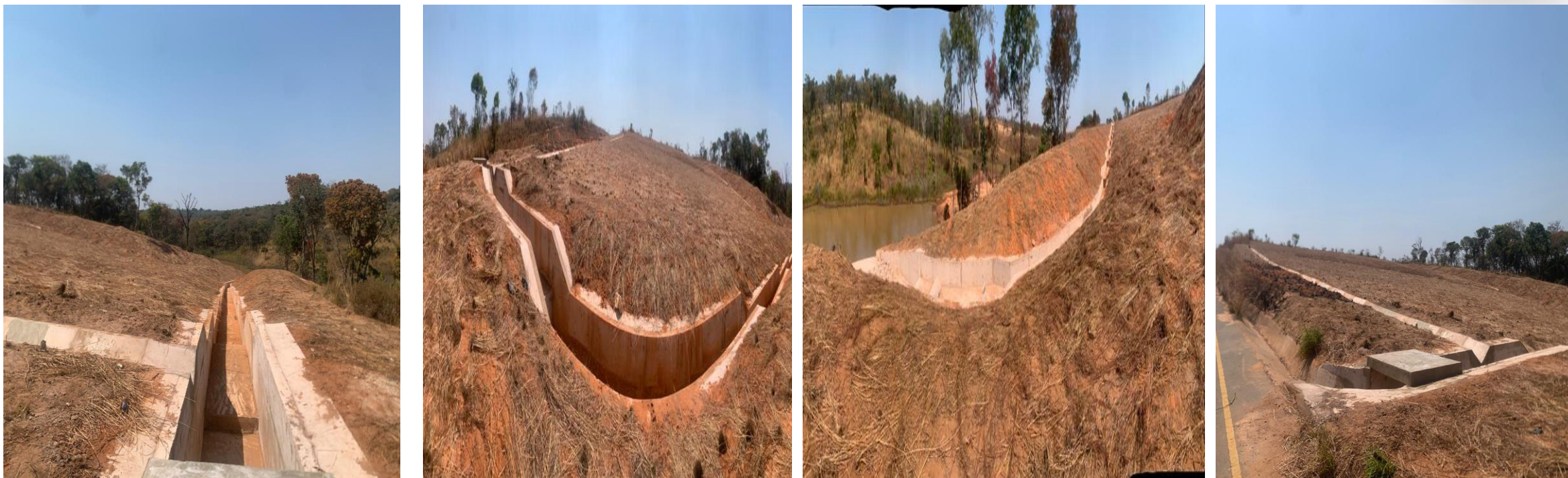
Figura 11: Contenção e estabilização da Ravina do Muamiombo, na EN 225, na Província da Lunda Norte
