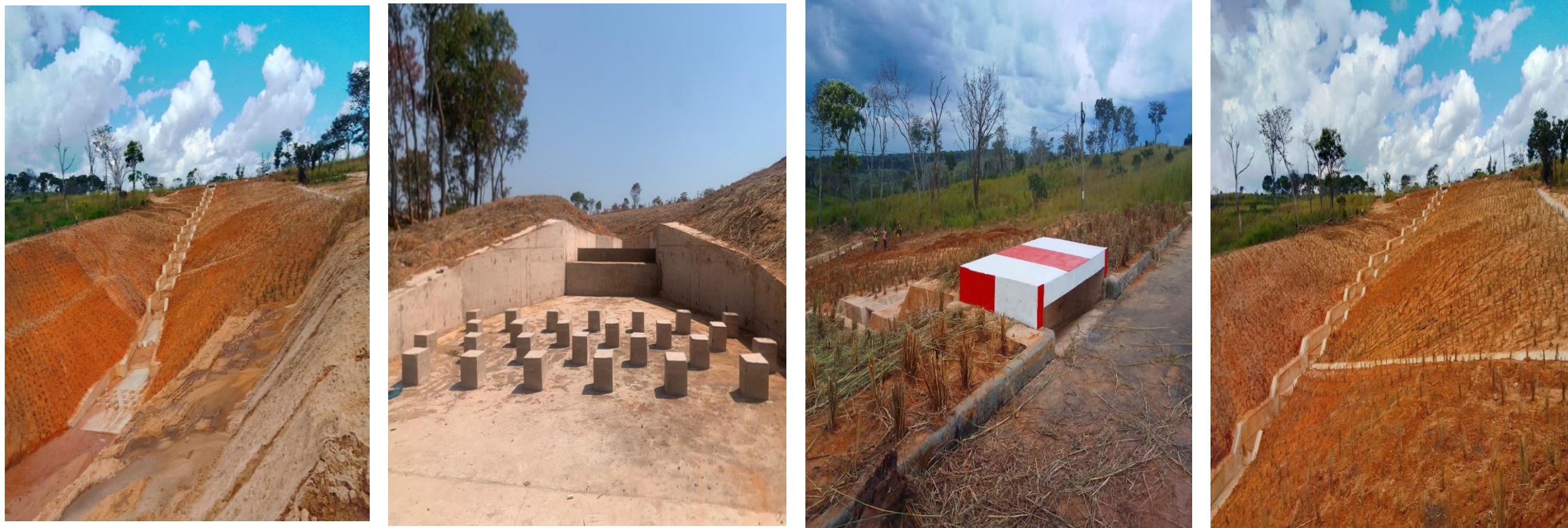
Figura 12: Contenção e estabilização da Ravina do Txipanda 2, na EN 225, na Província da Lunda Norte
